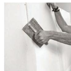
**12** Панели громкоговорителей Cerasoanar обработаны грунтовкой, что позволяет наносить на них штукатурку также как на окружающую поверхность. Таким образом можно легко получить гладкие поверхности стен/потолков 3-го и 4-го (Q3, Q4) класса шероховатости\*.
