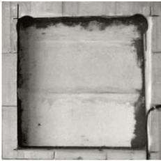
**1** Для установки невидимых громкоговорителей Cerasoanr требуется монтажный короб. Этот аксессуар доступен для всех моделей Concept и Reference. Для установки необходимо подготовить специальную нишу в стене (каменной кладке). Выемка должна быть примерно на 2мм больше чем внешний контур каркаса. Вставьте монтажный короб в выемку для проверки размеров.
