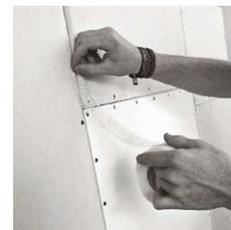
**10** Стыки между стеной/потолком и панелью должны быть проклеены серпянкой.
