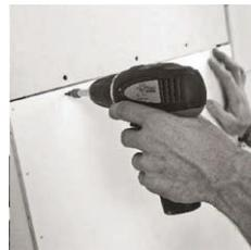
**8** Зафиксируйте панель саморезами в предварительно просверленные отверстия. Головки саморезов должны быть «погружены» в материал диафрагмы примерно на 1 мм.
