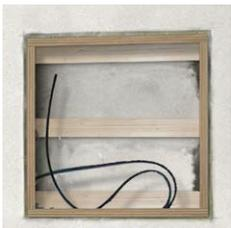
**4** Затем используйте дюбели минимального размера для крепления короба к стене. Последующие шаги совпадают с инструкцией по установке невидимых панелей в стены из гипсокартона.
