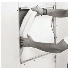
**5** Установите в нишу звукоизоляционный материал из комплекта поставки.
