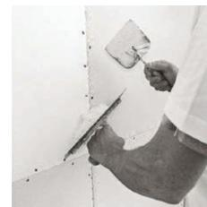
**11** Оштукатуривание и заделка швов и мест стыков, а также головок саморезов выполняется с использованием эластичной мелкодисперсной шпаклевки, которая обычно используется для внутренних работ.
