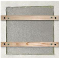
**3** При помощи двух перекладин можно легко установить короб в нишу и зафиксировать. Используйте монтажную пену для крепления каркаса по периметру к нише и подождите пока пена высохнет.
