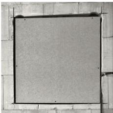
**2** Лучше всего монтировать панель в законченную стену. Т.е. стена уже должна быть оштукатуренной, чтобы можно было вставить панель заподлицо и затем нанести гладкую или рельефную штукатурку. Соединительный кабель должен быть вставлен в короб перед установкой панели.
